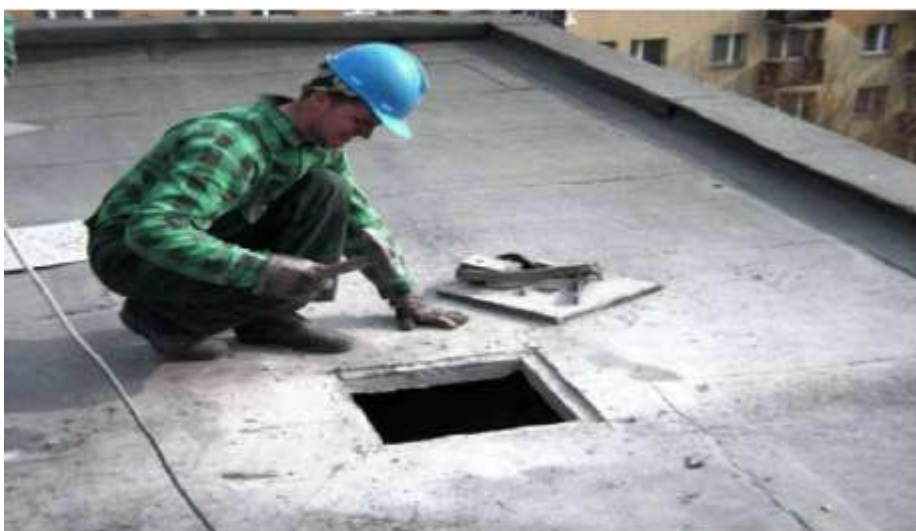
Zdj. Wykonanie otworu 50x50cm.
